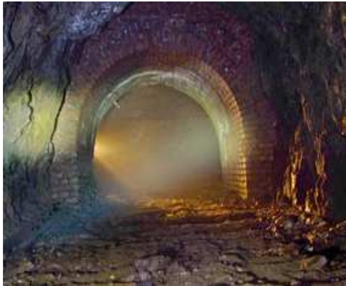
Förderstollen San Fernando 2014,
